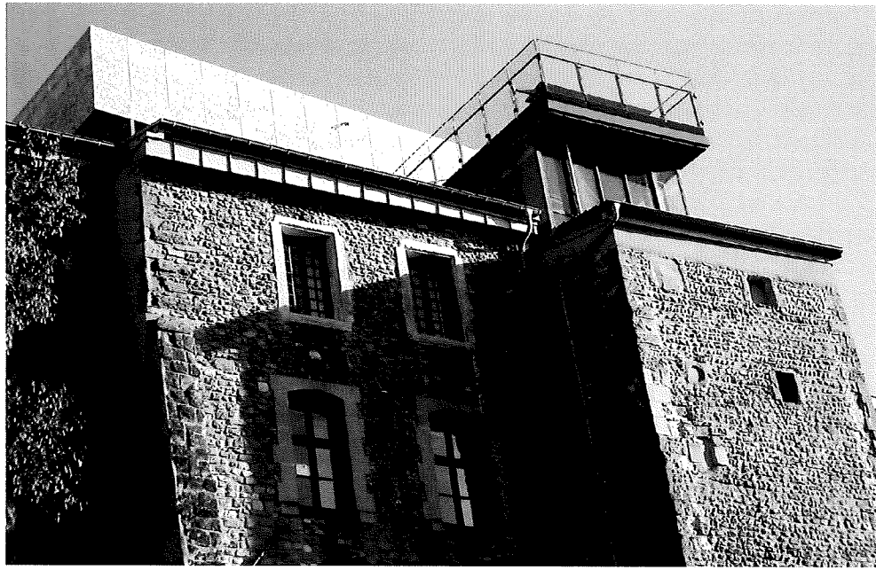
Le belvédère (cliché A.B.)
