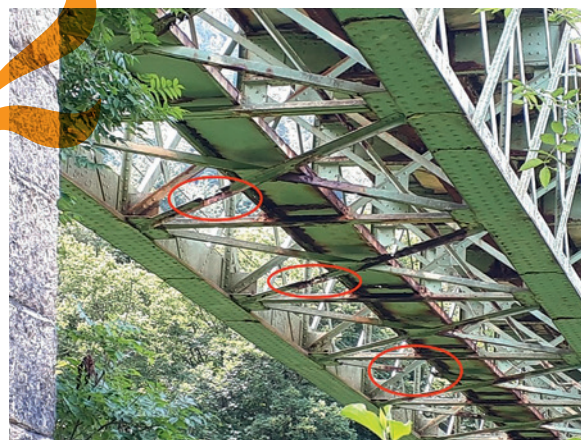
ill. 10 Corrosion et ruptures de barres de la poutre au vent. Corrosion du platelage de la plateforme de visite.
